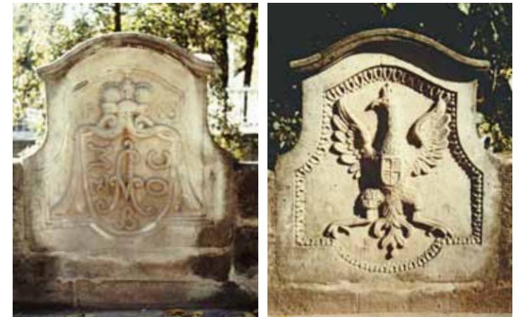
Brückensteine an der Aurachbrücke
