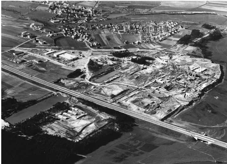
Großbaustelle Franken II
