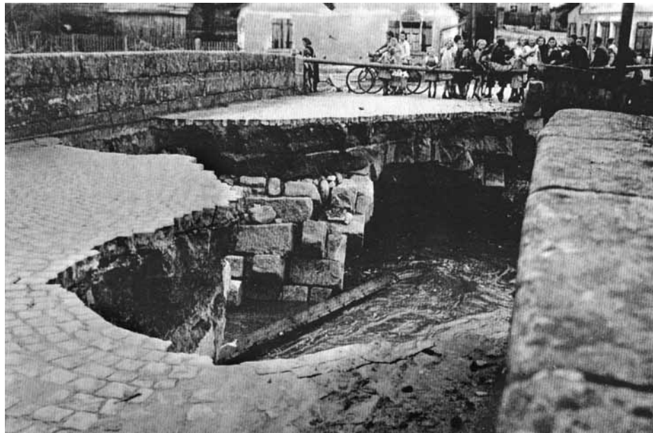
Die Aurachbrücke nach dem Hochwasser 1941
